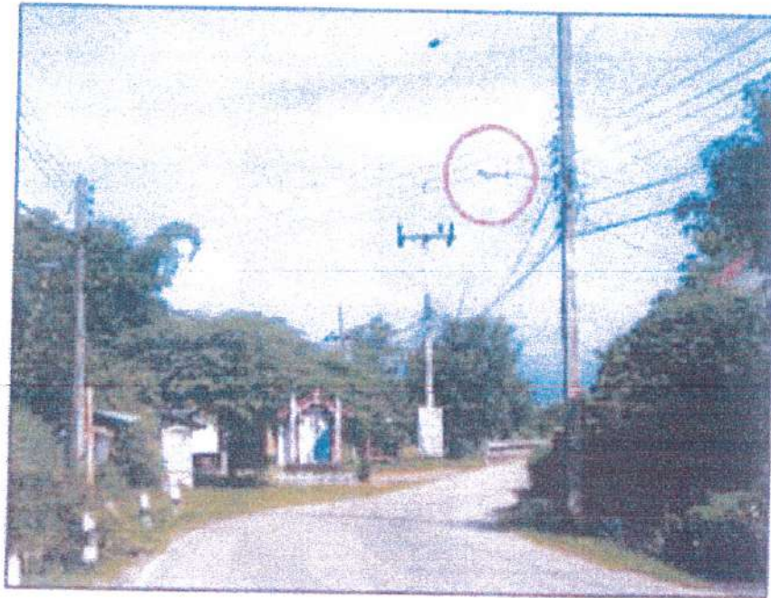
ภาพถ่ายประกอบตัวอย่าง ถนนสายหลักที่มีการติดตั้งไฟฟ้าสาธารณะตามจุดเสี่ยงต่าง ๆ ในเขตพื้นที่ตำบลบัวสลี อำเภอแม่อาย จังหวัดเชียงใหม่
